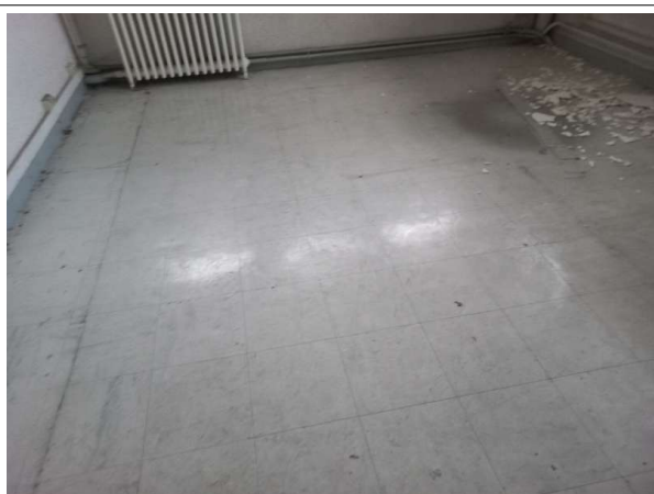
Prélèvement - P003 : OFB / RDC / Local RDC - 01 - Dalle de sol - AC1- (Présence d'amiante)
