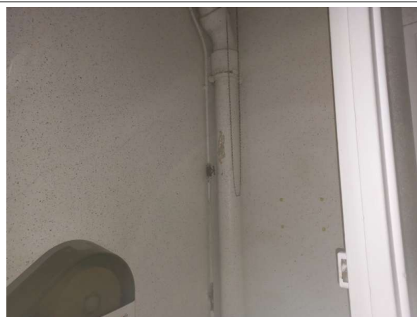
Déclaré - : OFB / R+1 / WC 2 - Conduit - EP- (Présence d'amiante)
