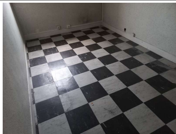
Prélèvement - P002 : OFB / RDC / Local RDC - 05 - Dalle de sol - AC1- (Présence d'amiante)
