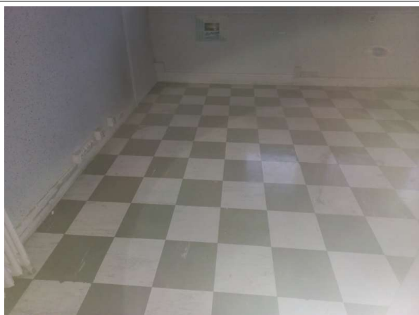
Prélèvement - P001 : OFB / RDC / Local RDC - 03 - Dalle de sol - AC1- (Présence d'amiante)
